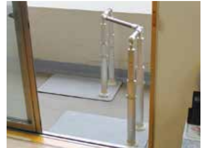
●ベランダへ降りる段差に設置
